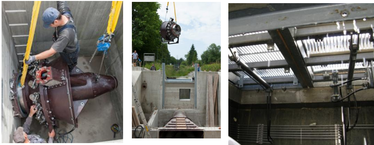
Abb. 6: Turbineneinbau (li. U. mi.), Blick aus dem Schacht noch oben (re.)
